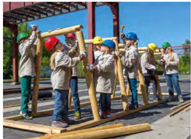
Abb. 2: Errichtung eines Stollenausbaus
